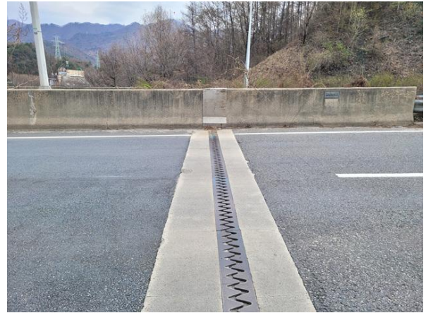
신축이음 A2 전경
