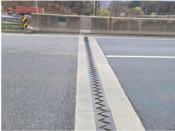
신축이음 A1 전경
