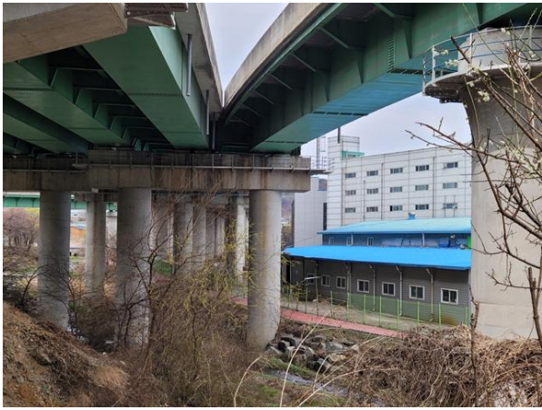
교각 P22 전경
