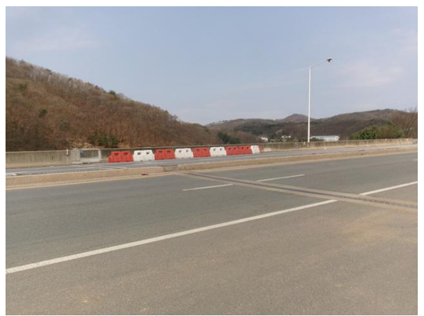
부대시설 가로등 전경
