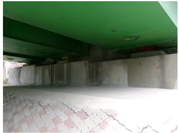
교대 A2 전경
