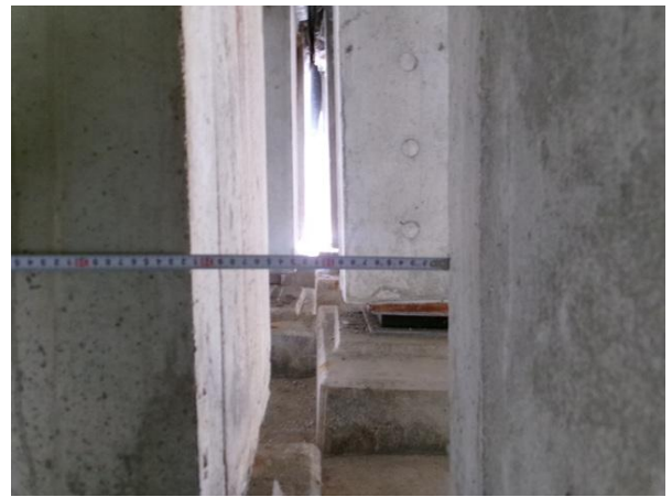
신축이음 하부 유간 측정 작업사진
