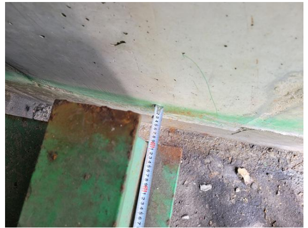
신축이음 하부 유간측정 작업사진
