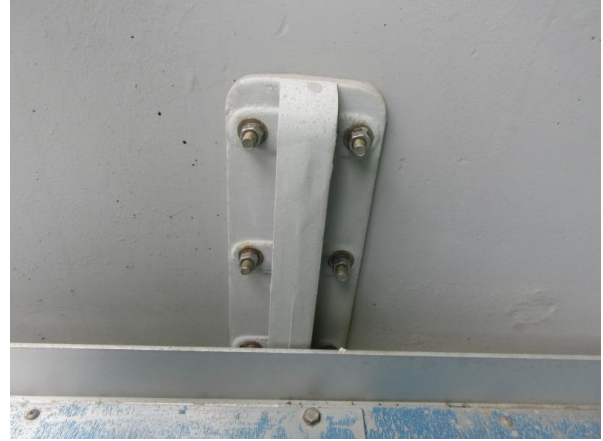
점검통로 고정장치 상태양호 P2
