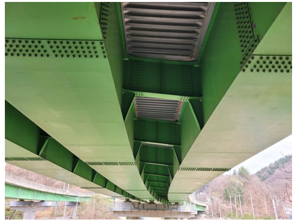
바닥판 하면 캔틸레버 전경
