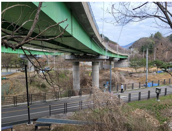
교각 P1 전경
