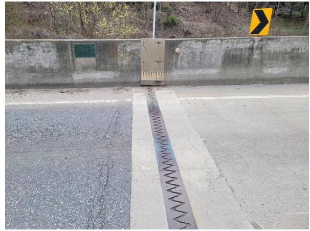
신축이음 A2 전경
