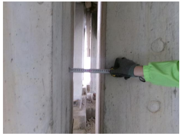
신축이음 하부 유간측정 작업사진
