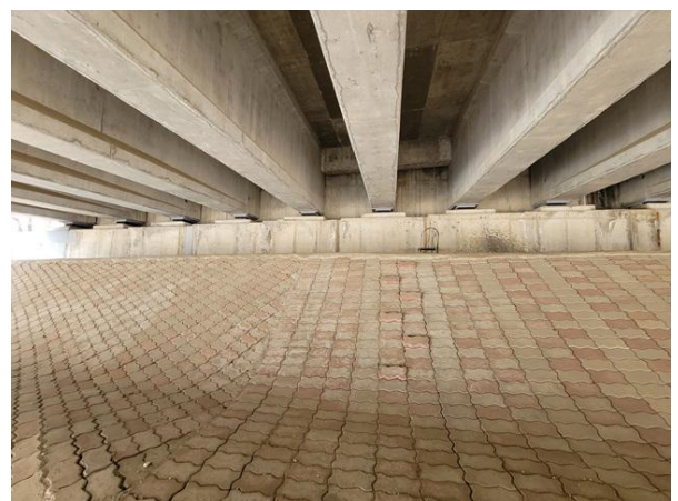
교대 A2 전경
