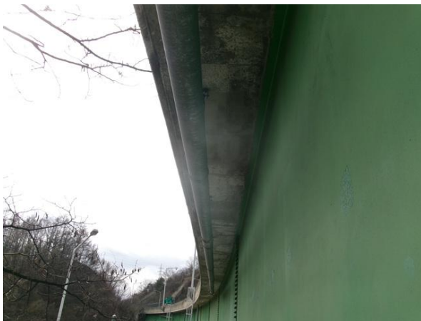
바닥판 하면 캔틸레버 전경
