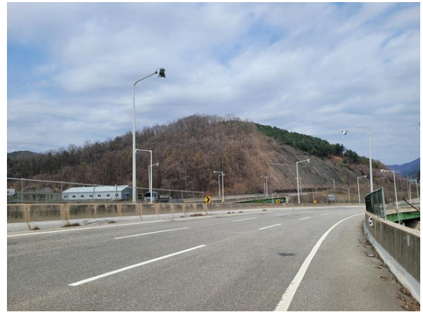
부대시설 가로등 전경
