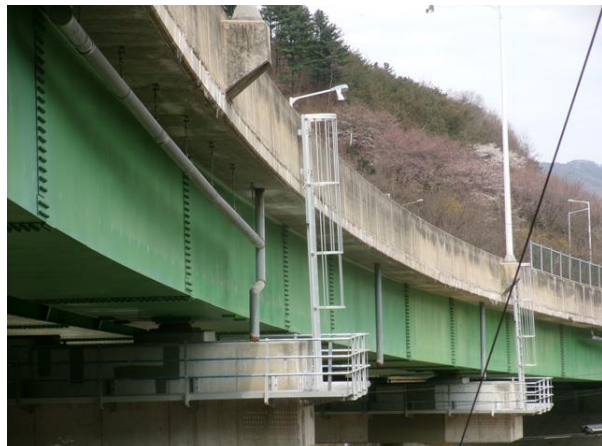
점검시설 상태양호 P1
