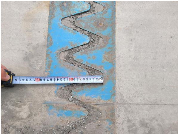
신축이음 유간 측정 작업사진
