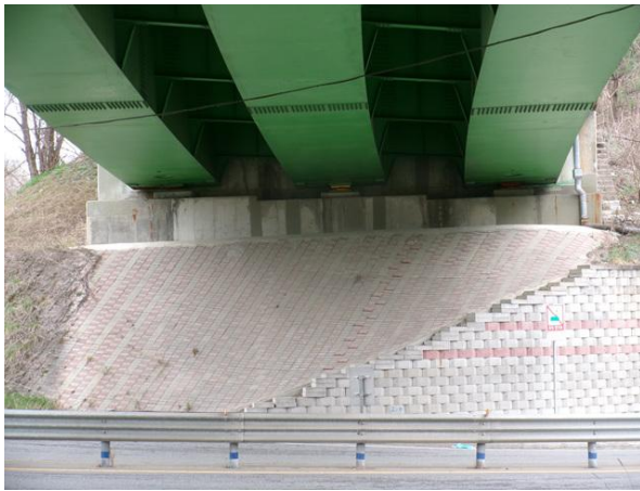
교대 A2 전경
