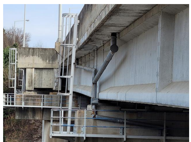
배수시설 배수관 전경
