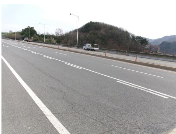
부대시설 가로등 전경
