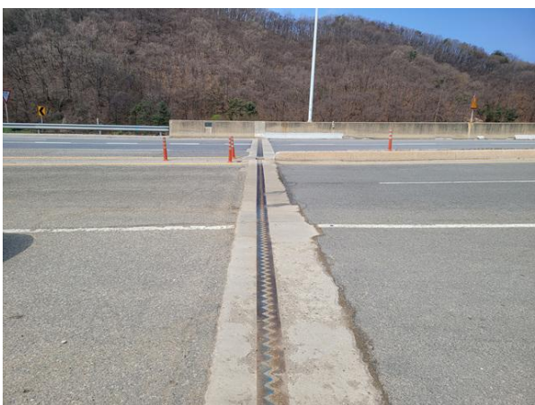
신축이음 A1 전경
