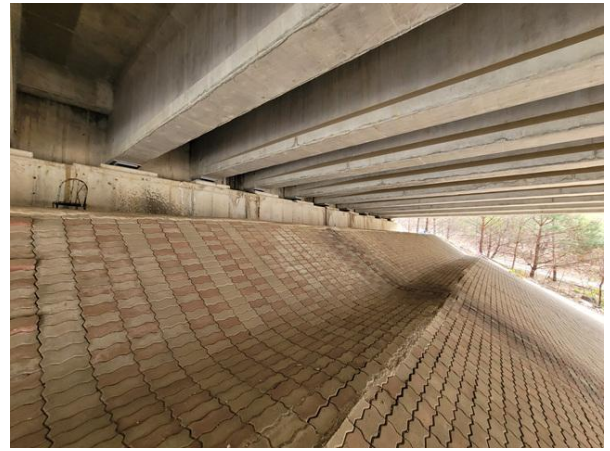
교대 A2 전경
