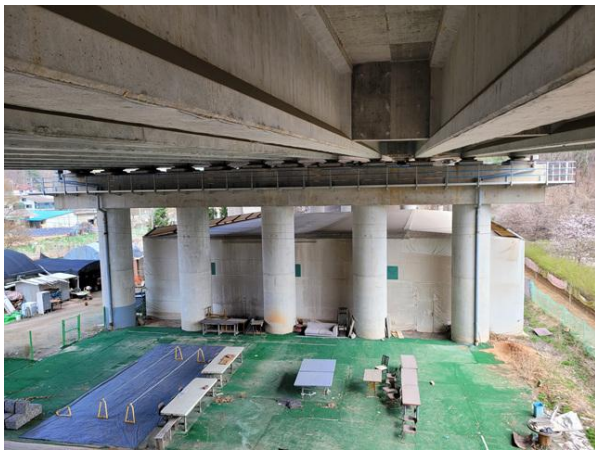
교각 P1 전경
