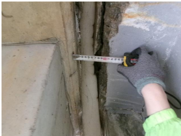
신축이음 하부 유간측정 작업사진
