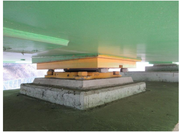
받침장치 상태양호 P2-SH2
