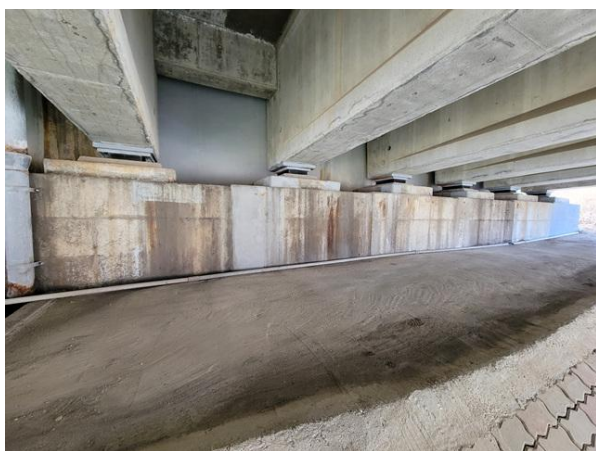
교대 A1 전경
