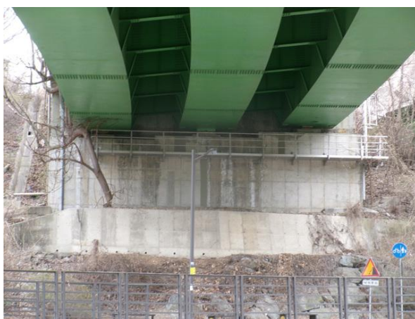
교대 A1 전경
