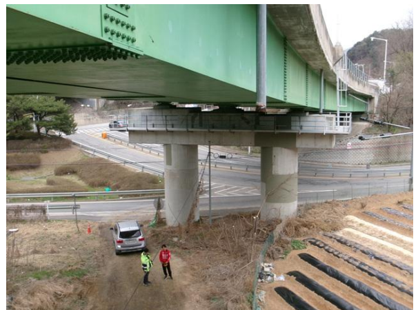
교각 P2 전경
