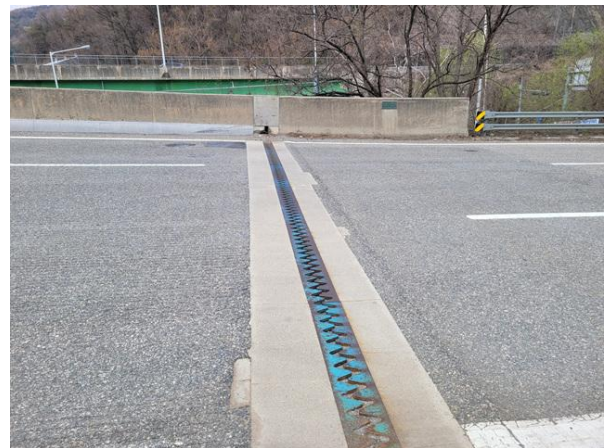
신축이음 A2 전경
