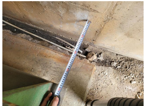
신축이음 하부 유간 측정 작업사진
