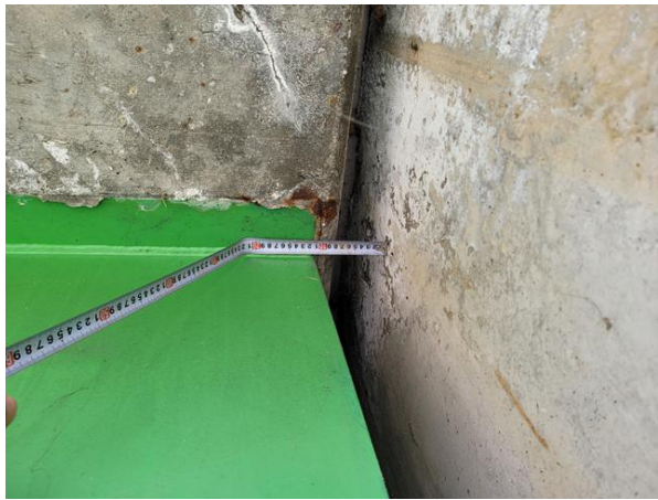
신축이음 하부 유간측정 작업사진
