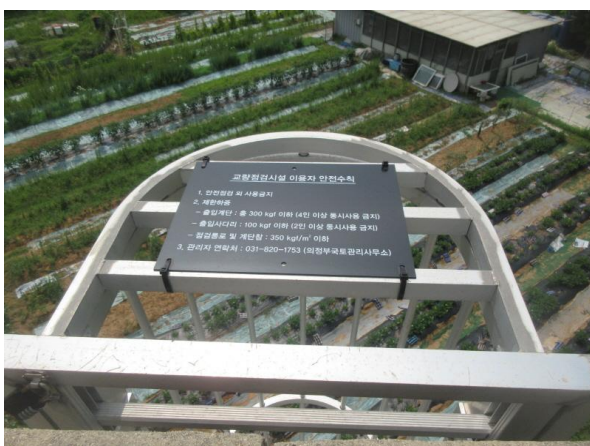
점검사다리 덮개 상태양호 P2
