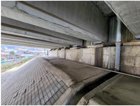
교대 A1 전경
