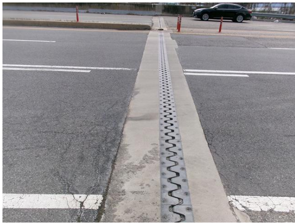
신축이음 A1 전경
