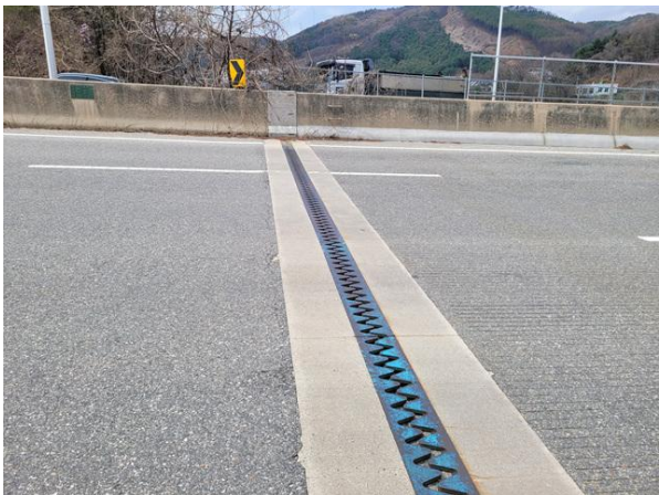
신축이음 A1 전경
