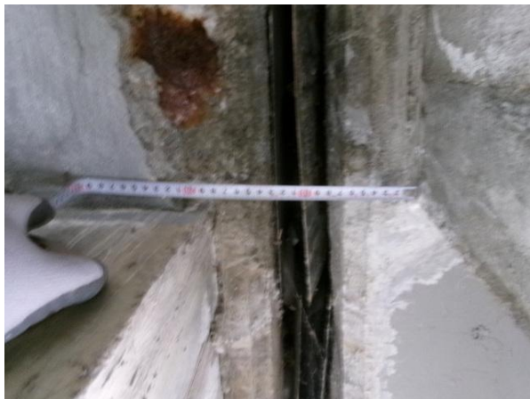
신축이음 하부 유간 측정 작업사진
