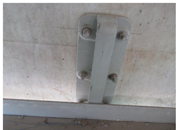
점검통로 고정장치 상태양호 P3
